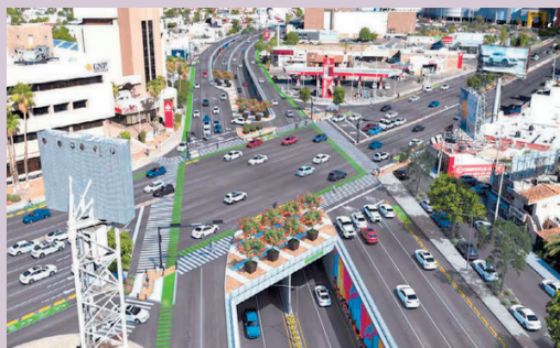
Ya se iniciaron los trabajos para un nuevo paso a desnivel en la transitada confluencia de los bulevares Colosio y Solidaridad en Hermosillo, que facilitará el tráfico y le dará una nueva fisonomía y modernidad a la capital de Sonora. Así quedará. ¡Felicidades!
